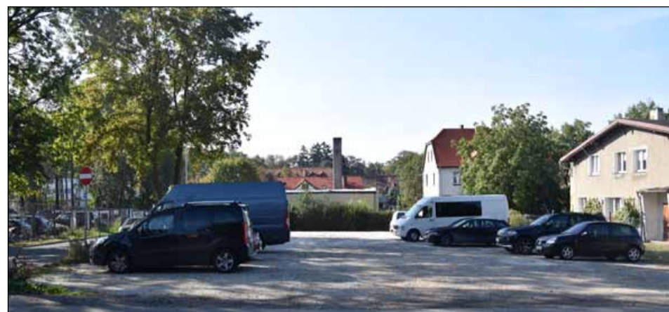
Wyburzenie budynku gospodarczego i wykonanie parkingu przy ul. Orkana w Obornikach Śląskich. Wartość: 40 000 zł.
