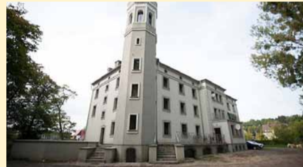
Rewitalizacja zabytkowego budynku w Obornikach Śląskich przy ul. Podzamcze 7
