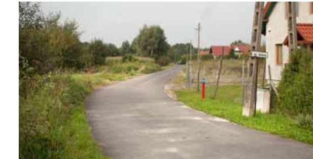
Nakładka na ul. Zielonej w Gołdźzinowie
