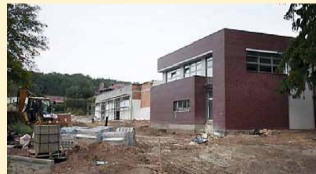
Budowa Stacji Uzdatniania Wody w Obornikach Śląskich
