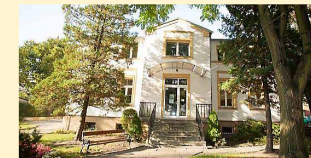
Rozpoczęcie pierwszego etapu remontu Obornickiego Ośrodka Kultury
