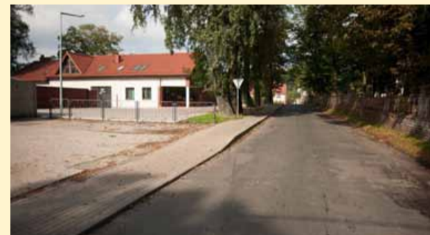
Budowa chodników przy ulicach Podzamcze i Trzebnicka w Obornikach Śląskich
