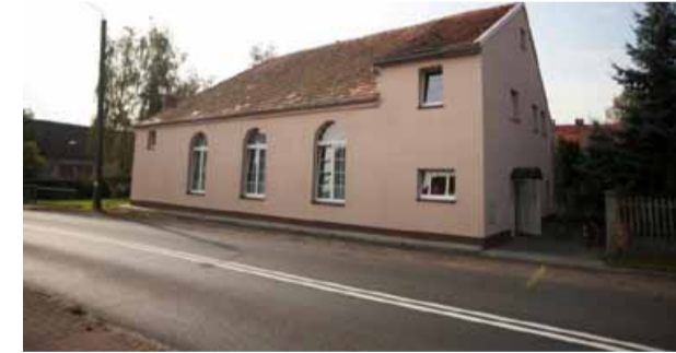
Remont świetlicy w Zajączkowie na „Centrum Aktywności Społecznej
