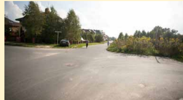
Położenie nowego dywanika asfaltowego na ul. Fredry w Obornikach Śląskich
