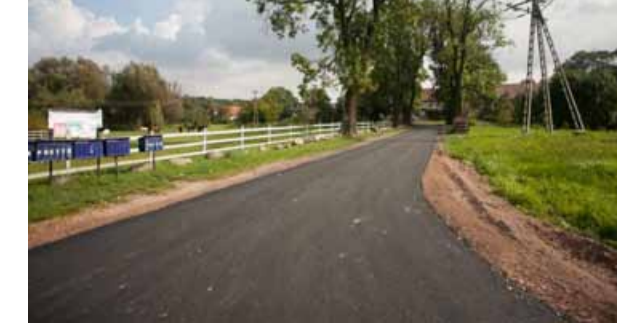
Wykonanie nakładki asfaltowej na ul. Jesionowej w Kuraszowie
