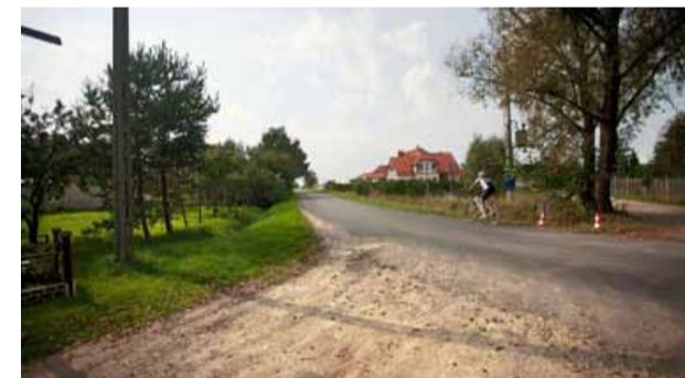
Remont części drogi z Wielkiej Lipy do Rościławic
