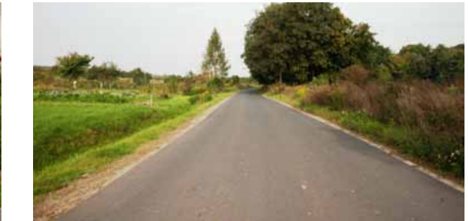
2,5 km nakładki asfaltowej na odcinku drogi Kowale – Marcinów
