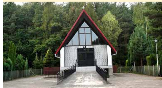
Remont Kaplicy Cmentarnej na Cmentarzu Komunalnym w Obornikach Śl. wraz z ogrzewaniem
