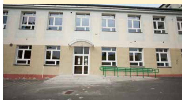
Remont wejścia do Szkoły Podstawowej nr 2 w Obornikach Śląskich z dostosowaniem dla potrzeb osób niepełnosprawnych
