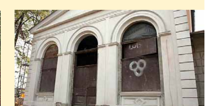
Doprowadzenie poprzez negocjacje z PKP do remontu Dworca Kolejowego w Obornikach Śląskich oraz uzyskanie nowej lokalizacji dla Biblioteki Miejskiej wraz z wyposażeniem
