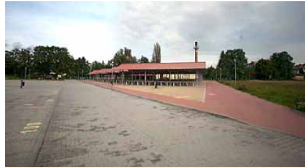
Budowa nowoczesnego targowiska miejskiego w Obornikach Śląskich "MÓJ RYNEK" Jest to jedna z największych inwestycji ostatnich lat
