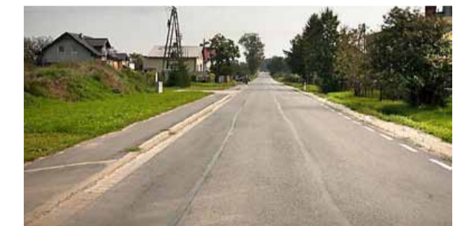
Budowa chodnika przy ul. Dworcowej w Pęgowie
