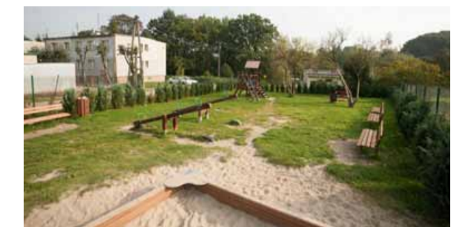
Kowale – budowa placu zabaw
