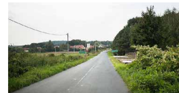
Nakładka na drodze Morzęcin Wielki – Siemianice
