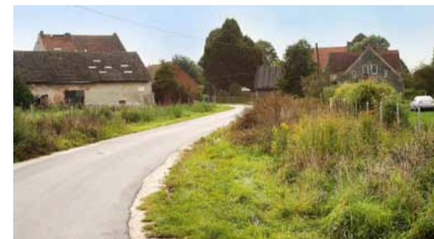
Nakładka asfaltowa na ul. Leśnej w Lubnowie
