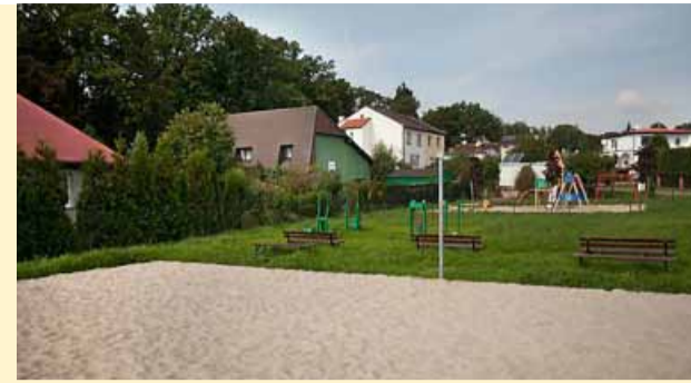
Wykonanie boiska do siatkówki plażowej wraz z montażem siłowni na świeżym powietrzu na ul. Korzeniowskiego w Obornikach Śląskich
