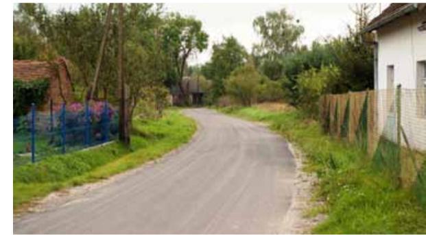
Remont ulicy Leśnej w Jarach
