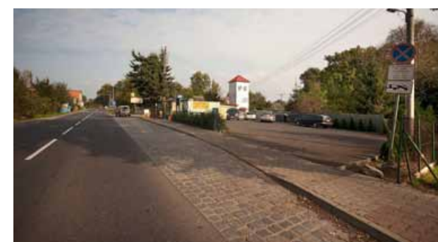
Utwardzenie placu parkingowego za przystankiem w Zajączkowie
