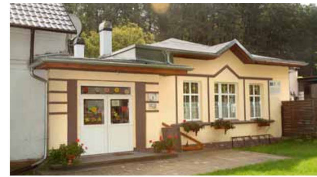
Remont dachu oraz wnętrza świetlicy w Osoli
