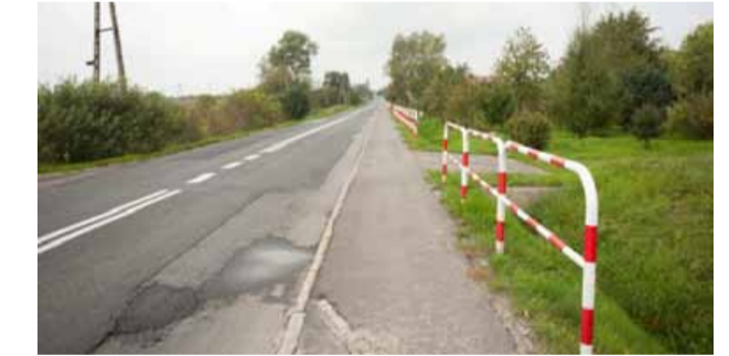
Budowa chodnika przy drodze wojewódzkiej 50%/50% w Rościslawicach
