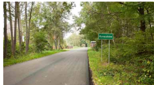
Remont drogi powiatowej Oborniki Śląskie – Kuraszków 50% / 50%
