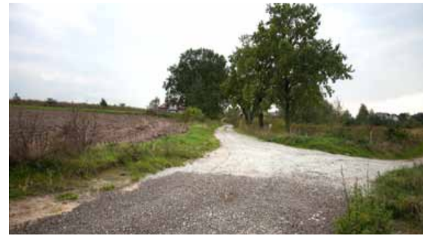
Utwardzenie drogi w Siemianicach na ul. Złotej
