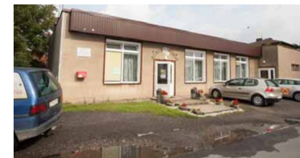
Remont wnętrza świetlicy wiejskiej w Paniowicach wraz z doposażeniem
