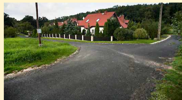
Wykonanie nakładek asfaltowych na ul. Leśnej i Jodłowej w Obornikach Śląskich
