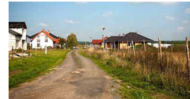
Montaż nowych punktów oświetleniowych w Urazie
