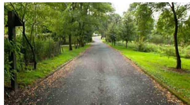
Wykonanie nakładki na ulicy dojazdowej do Schroniska w Kuraszkowie
