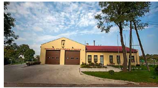
Budowa Remizy OSP w Pęgowie
