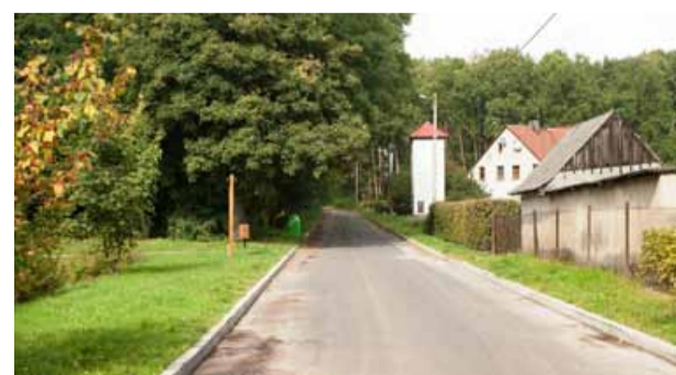
Budowa drogi na ul. Leśnej w Osoli
