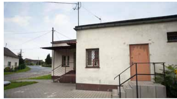
Remont świetlicy w Siemianicach wewnątrz budynku wraz z wykonaniem ogrzewania
