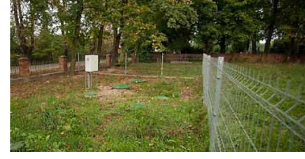
Budowa oczyszczalni ścieków dla kompleksu edukacyjnego w Pęgowie
