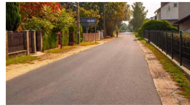
Nakładka asfaltowa na ul. Krótkiej w Pęgowie
