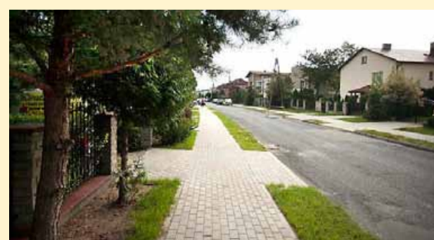
Wykonanie chodnika przy ul. II Armii Wojska Polskiego w Obornikach Śląskich
