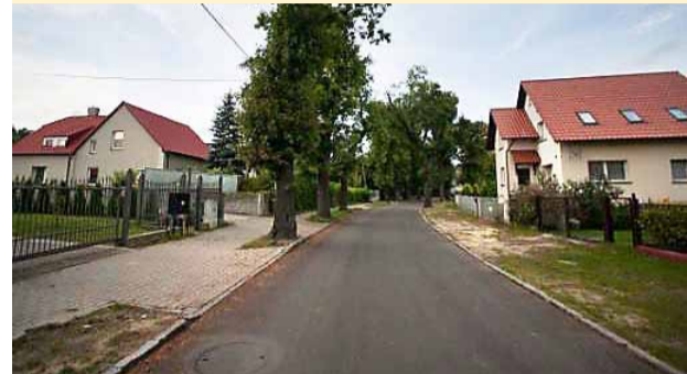
Modernizacja kanalizacji wraz z remontem drogi przy ul. Dębowej w Obornikach Śląskich
