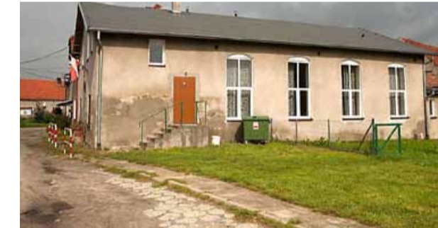
Lubnów – remont dachu świetlicy
