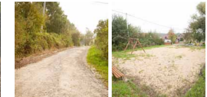
Utwardzenie drogi w Piekarach wraz z odwodnieniem Budowa placu zabaw w Piekarach
