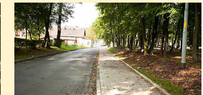
Remont chodnika przy ul. Paderewskiego w Obornikach Śląskich
