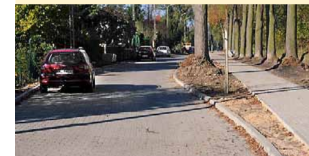
Przebudowa drogi wraz z ciągiem pieszym przy ul. Kasztanowej w Obornikach Śląskich
