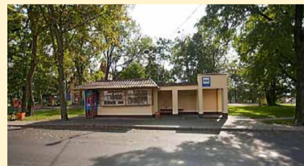
Całościowy remont przystanku autobusowego na ul. Trzebnickiej w Obornikach Śląskich
