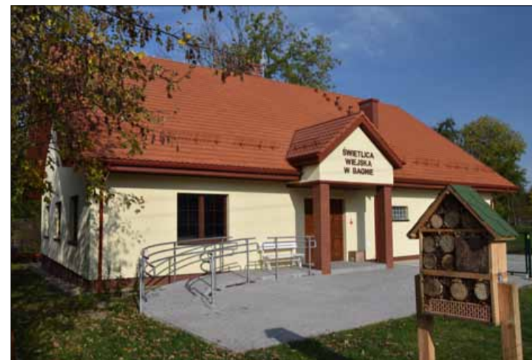
Świetlica wiejska w Bagnie.
