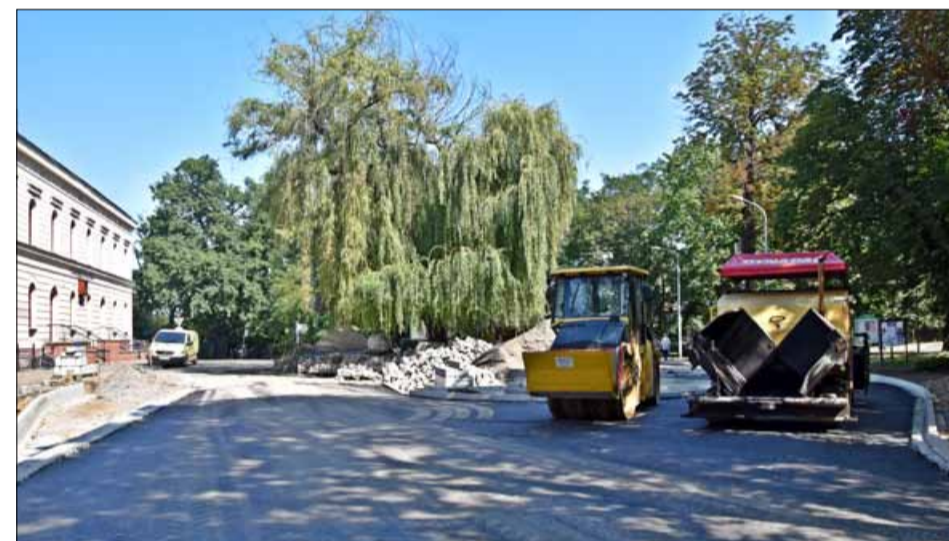
Remont przy dworcu PKP.
