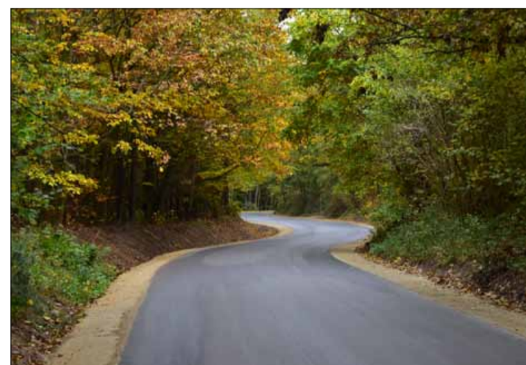
Fragment przebudowanej drogi.
