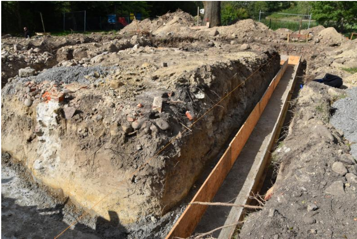
Fundamenty świetlicy w Bagnie
