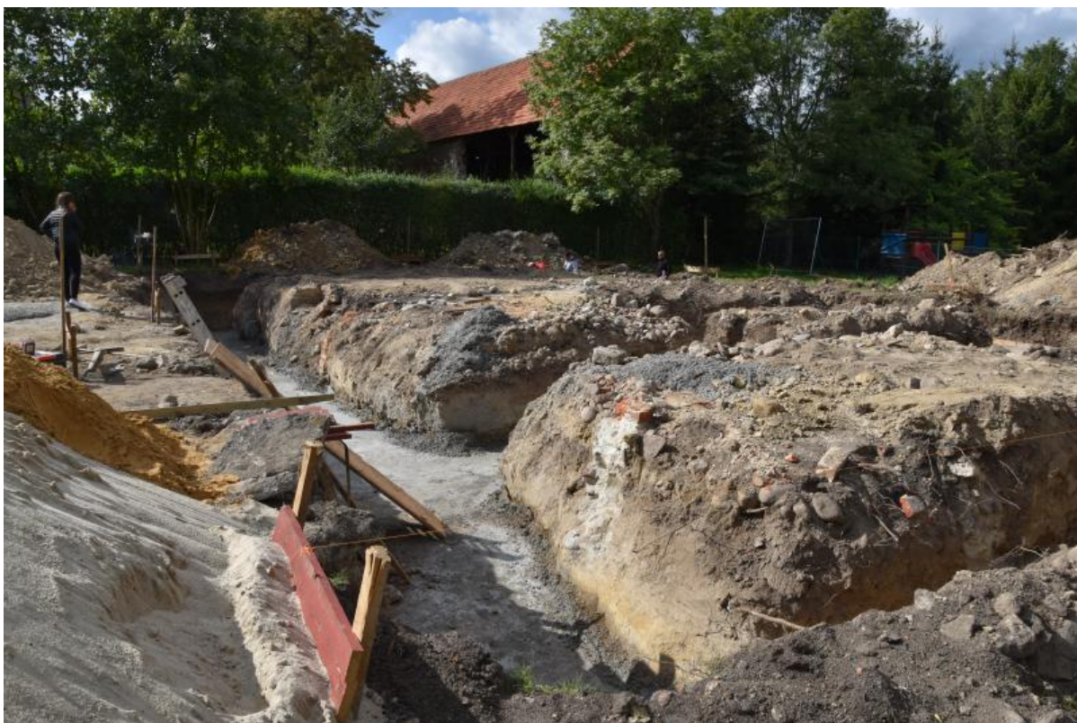
Fundamenty świetlicy w Bagnie
