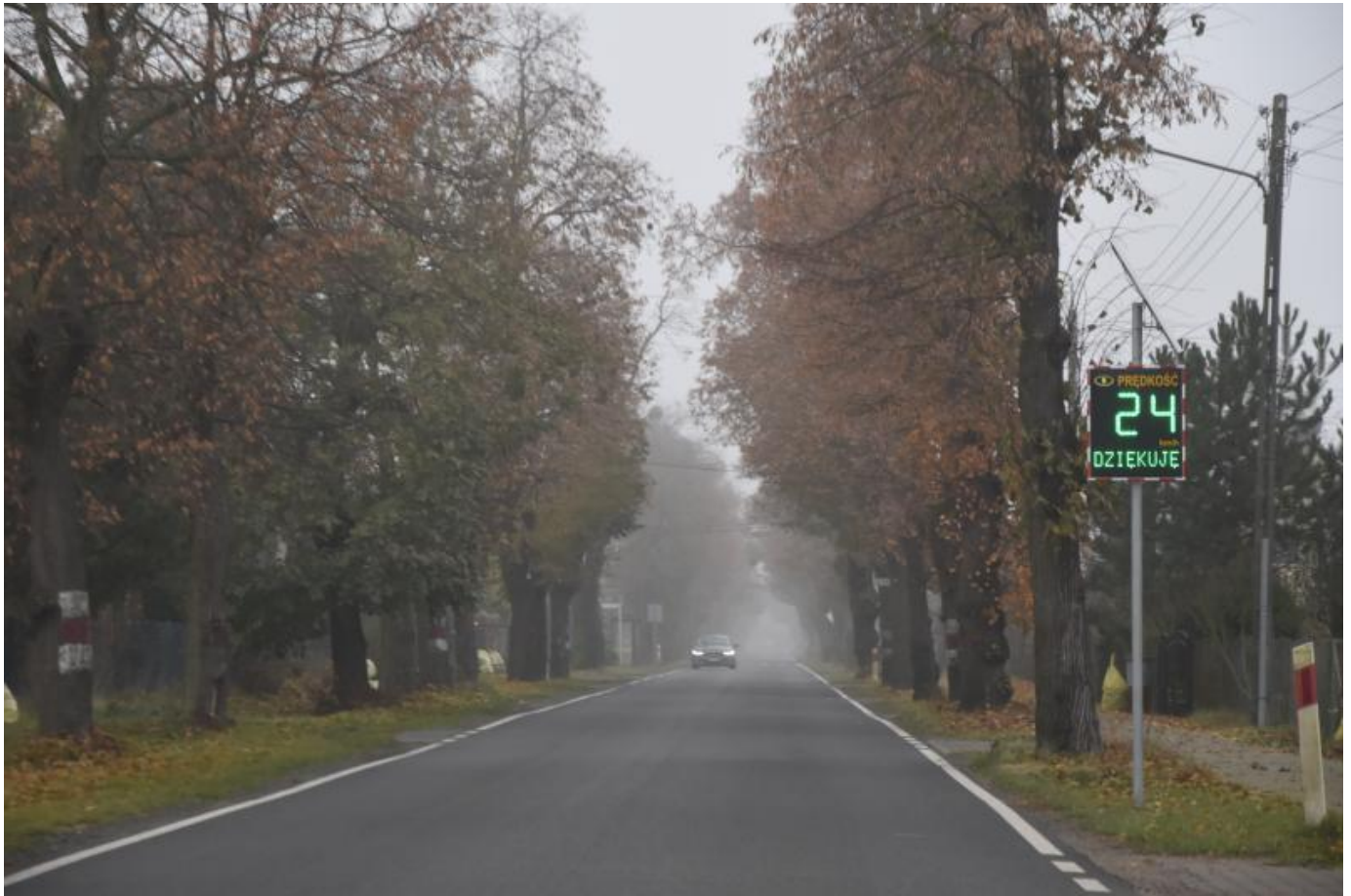
Uraz, ul. Brzeska (wjazd od Brzegu Dolnego)
