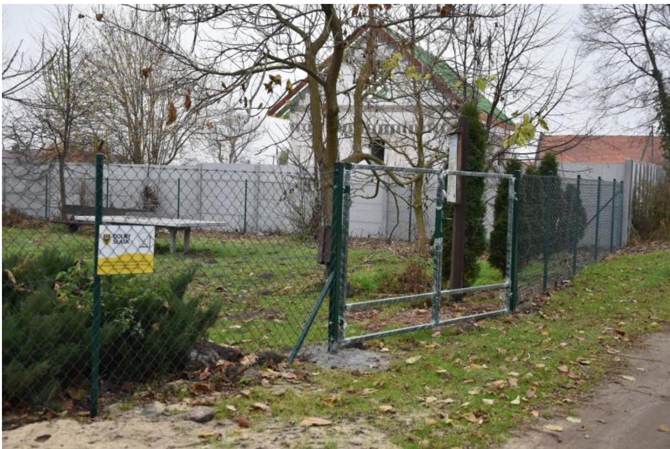
Ogrodzenie w Rościśławicach
