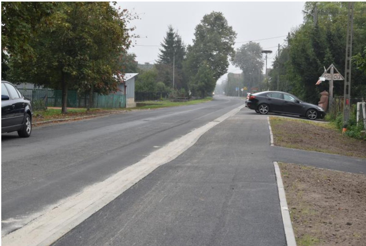
chodnik w Kotowicach
