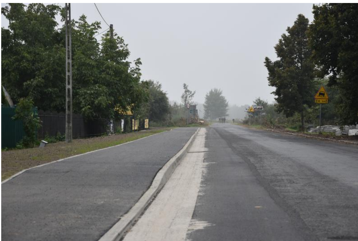
chodnik w Kotowicach
