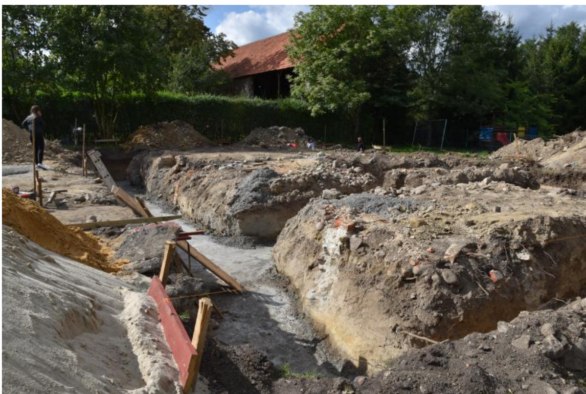
Fundamenty świetlicy w Bagnie
