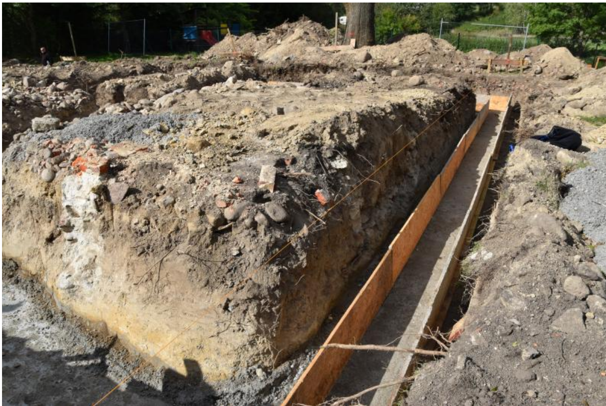
Fundamenty świetlicy w Bagnie
