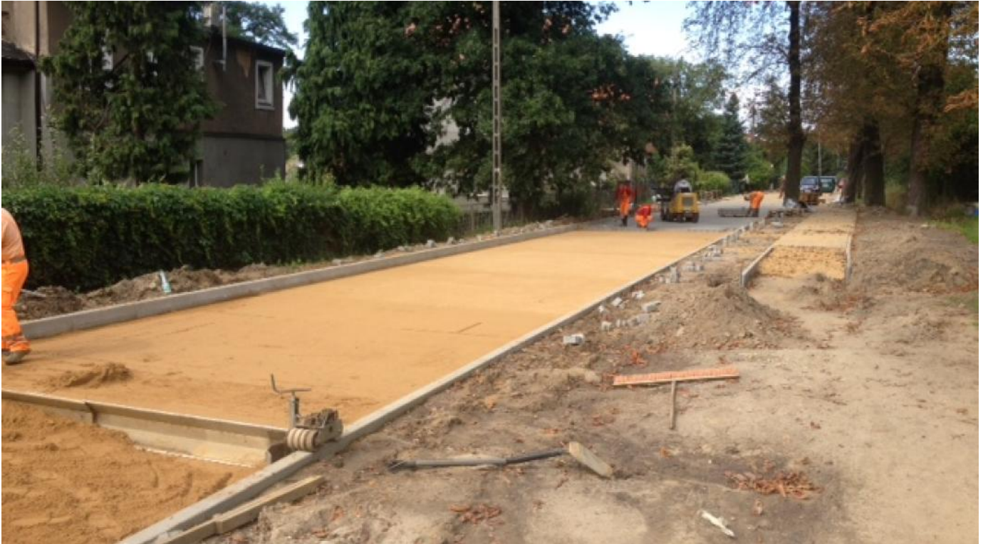
Ulica Kasztanowa w Obornikach Śląskich w trakcie remontu!
